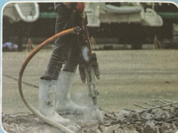
อุปกรณ์เครื่องจักรที่ก่อให้เกิดการสั่นสะเทือน เช่น การเจาะหิน เจาะถนน
